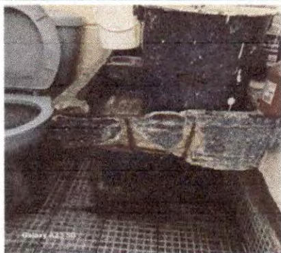
Foto 15: sustitución de pila de cemento de un labadero
