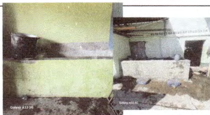
Foto 11: reparación o sustitución de azulejos
