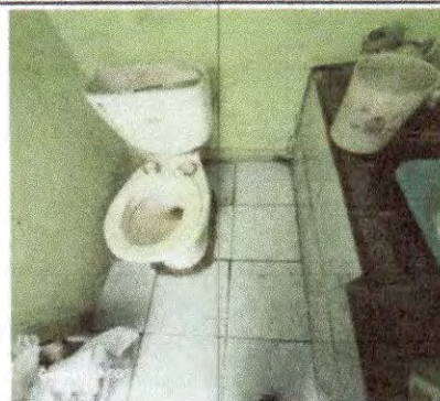
Foto 8 : servicio sanitarios y sus accesorios: sustitución de inodoro:
