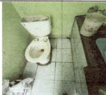
Foto 6: servicio sanitarios y sus accesorios: sustitución de inodoro
