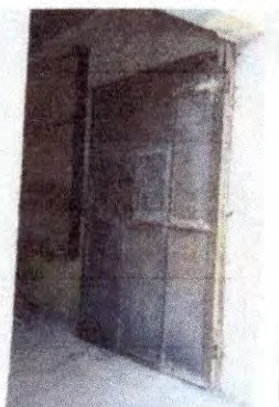
Foto 13 : fabricación e instalación de puertas de metal.
